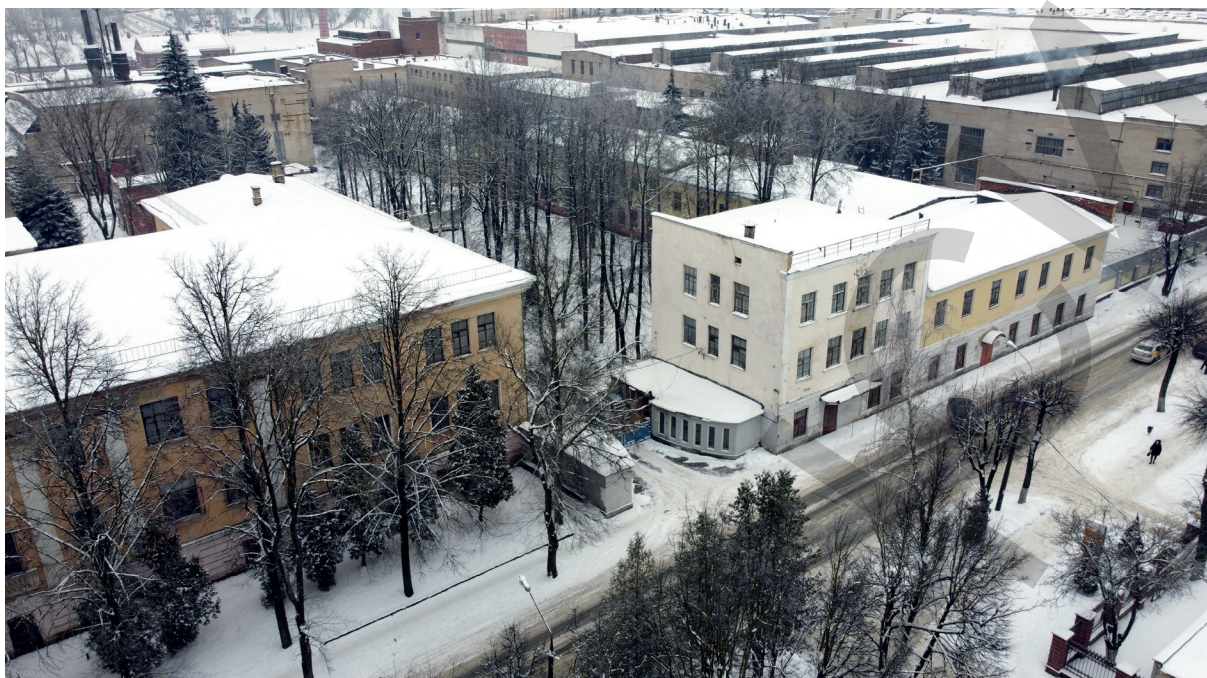
Правое фасадное здание на быв. Канатной – быв. столовая и кухня. Фото А. Гергаева
