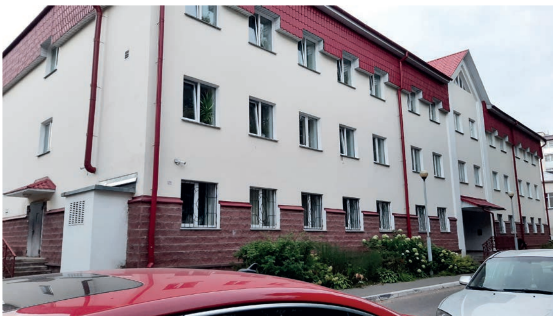
Витебская дистанция сигнализации и связи, управление железными дорогами и их обслуживание на ул. Орджоникидзе, 3. 2025. Фото Г. Орловского
