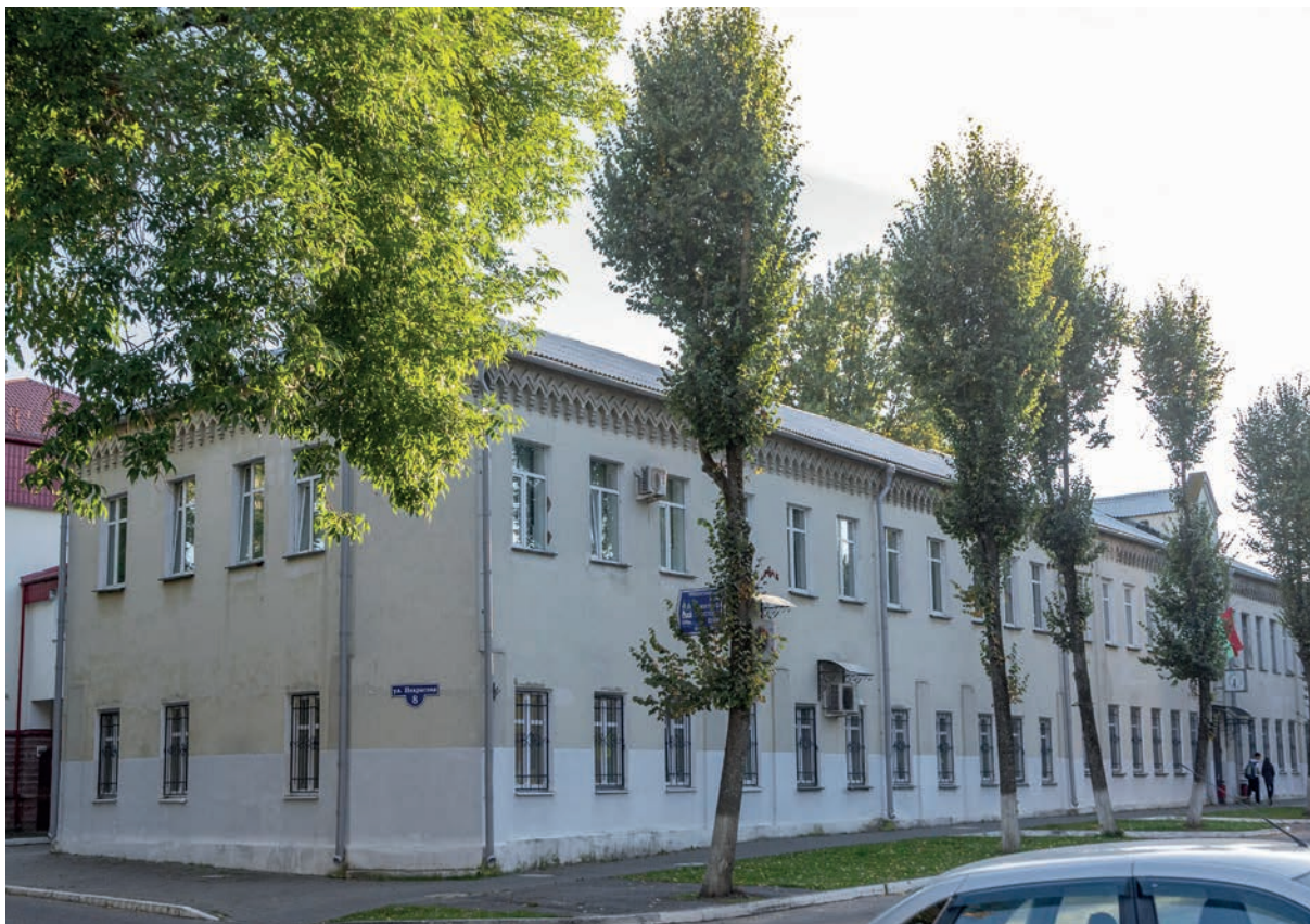
Угол улиц Орджоникидзе (быв. ул. Екатерининской) и ул Некрасова (быв. ул. Большой Елагской). Часть здания расположена на месте дома 1/20. Фото Г. Орловского. 2025 г.
