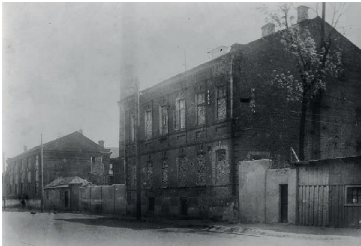
Дома № 11 и № 13 по Задуновской улице
