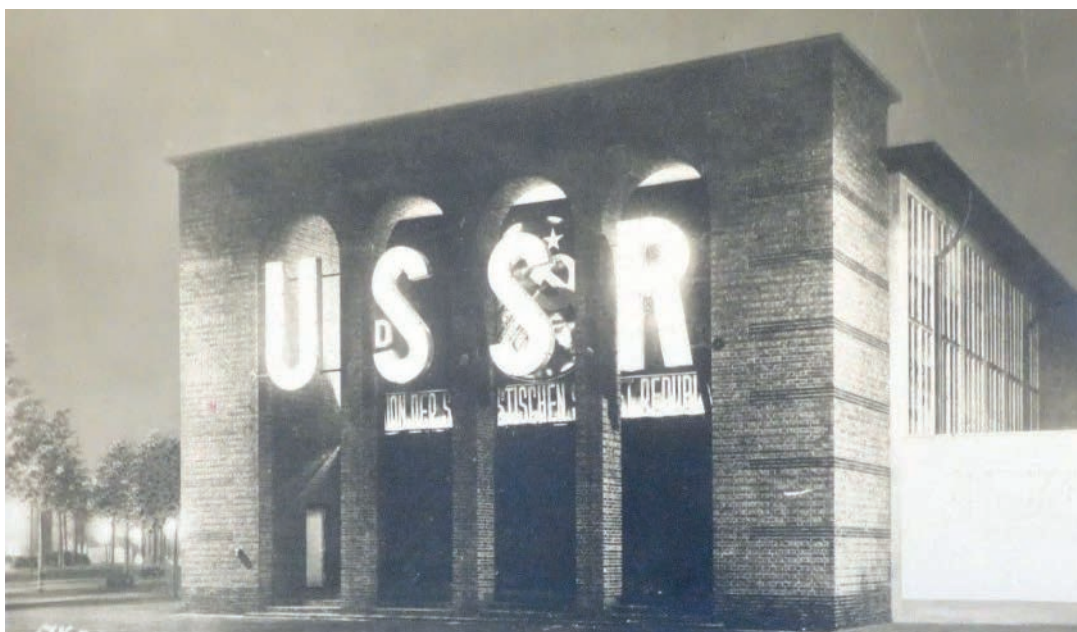
Вход в павильон на выставке «Пресса» в Кельне. 1928
