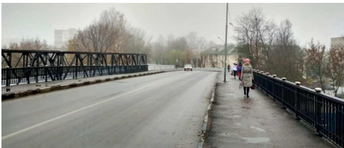
Путепровод Металлистов. Фото из сети
