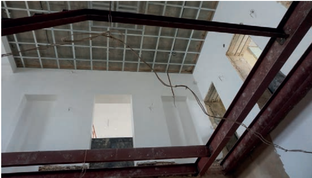
«Колодец» здания вид на ниши и двери верхнего этажа
