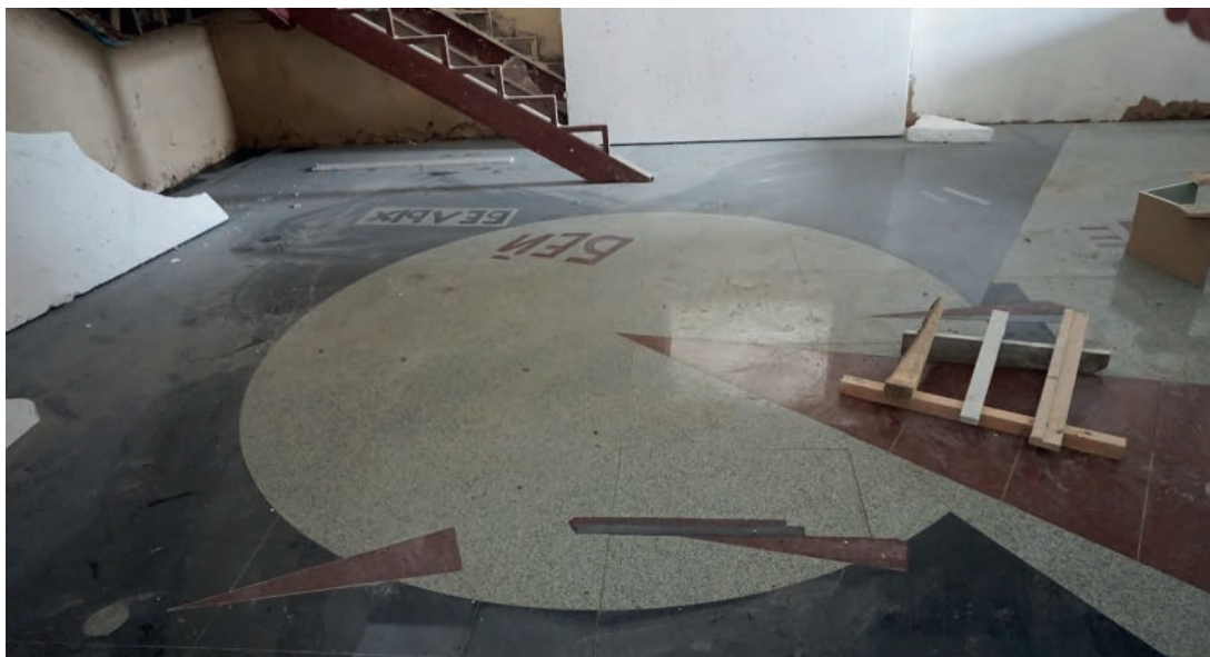
Начало работы по укладке гранита в центре музея
