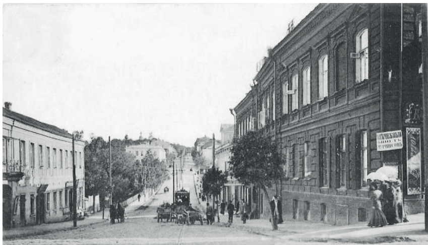
Справа на фото дом на Гоголевской, 1, угол Замковой, в котором жил Ю. Пэн
