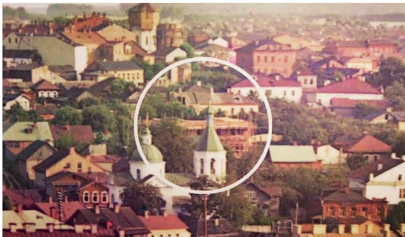
1912 год. Строящийся дом Израиля Вишняка. С фотографии Сергея Прокудина-Горского. Здание Витебского народного художественного училища (с 1919 по 1923 г.)
